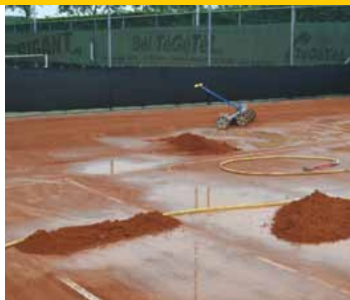
2. Gravel 0-2 mm aanvoeren op het speelveld.
