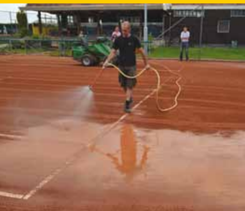
1. Na bewerking met de staalborstel gravel bevochtigen met de handbroes.
