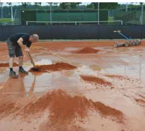
3. Met de schop de droge gravel over de ondieptes verdelen.
